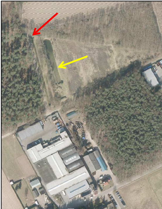
Figuur 21. Plangebied en ten noorden daarvan gelegen perceel met de greppel voor opvang van hemelwater (rode pijl), de vijver ten behoeve van opvang van koel-/spoelwater (en gele pijl)
