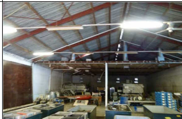
Te slopen dichte schuur
