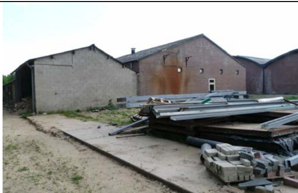
Te slopen schuren, noordzijde
