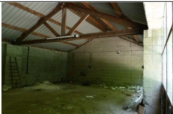
Te slopen dichte schuur
