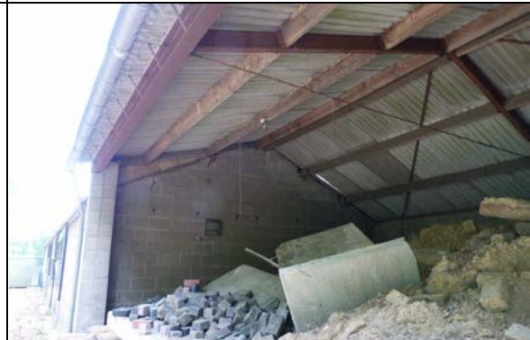
Te slopen open schuur
