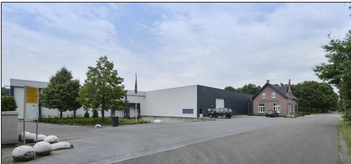
Foto vooraanzicht bedrijfslocatie met bedrijfsgebouwen en bestaande inrit voor vrachtwagens (links naast bedrijfsgebouw)
