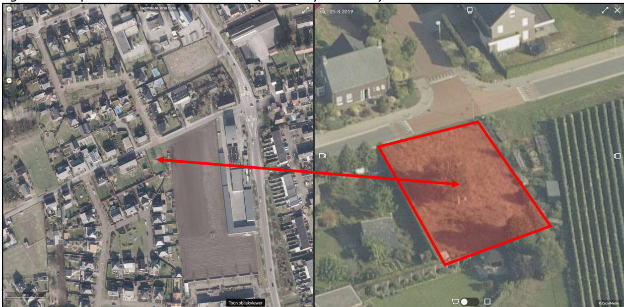
figuur 1: impressie onderzoekslocatie (bron: CycloMedia):
