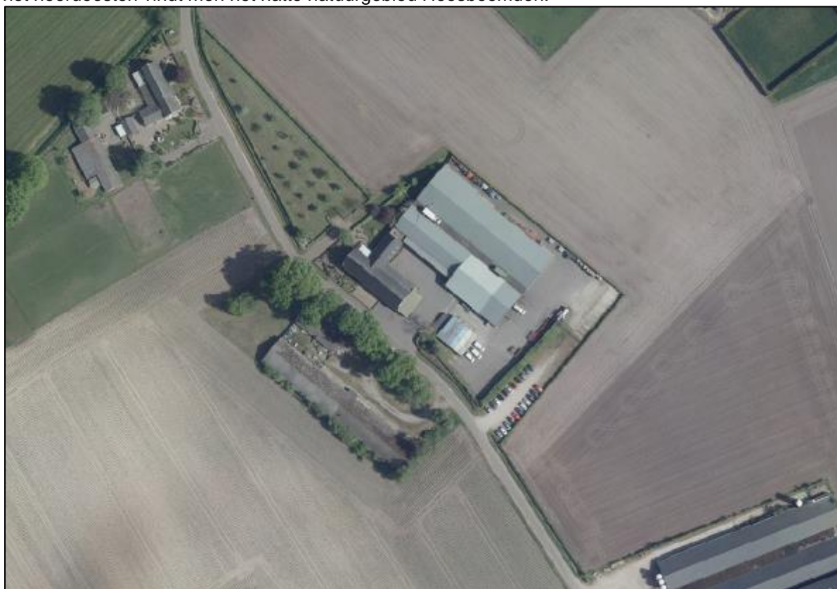
afbeelding 5, Luchtfoto bestaande situatie
