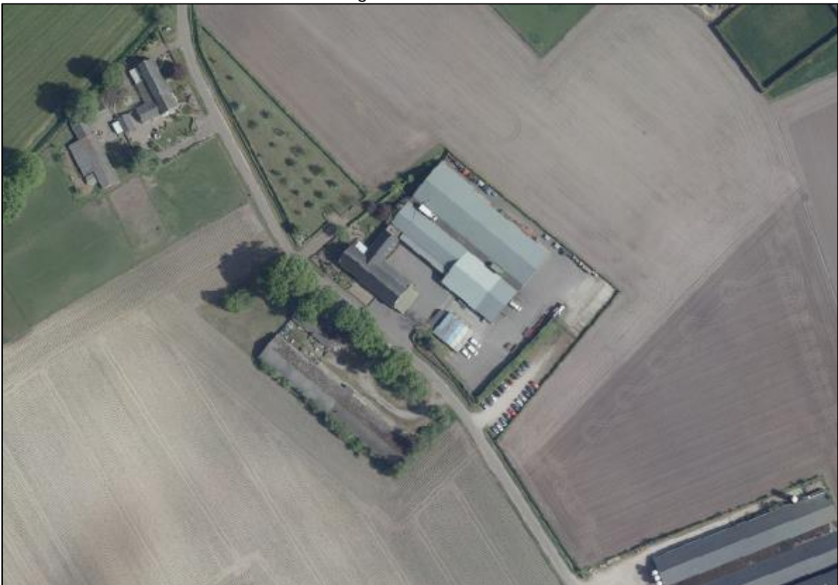
afbeelding 5, Luchtfoto bestaande situatie
