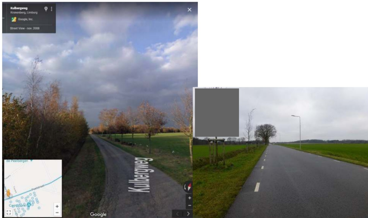
Links: Kulbergweg westz.jde in 2008. Rechts: Kulbergweg westz.jde meer naar het noorden in 2018. De wegen zijn breder waardoor er harder gereden wordt en het is veel drukker geworden.
