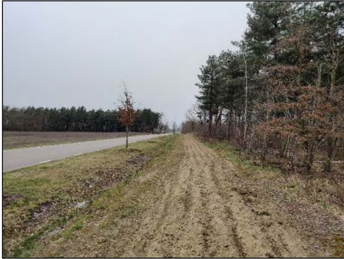
Figuur 2: Travers: verbreed, geasfalteerd en aan de zijkant is een breed ruiterpad aangelegd.
