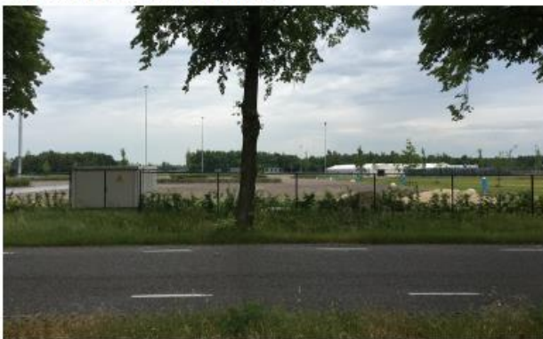
Zicht parkeerterrein ter hoogte van trafo
