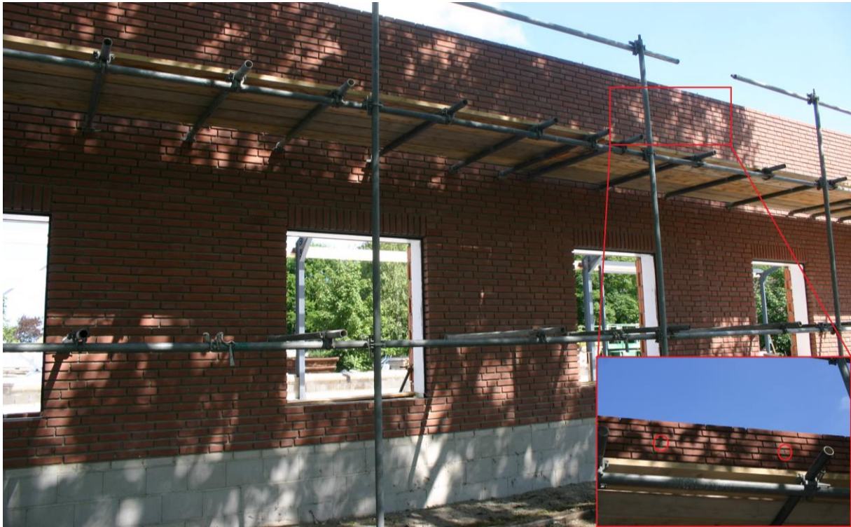
Figuur 4.2. De reeds opgemetselde muur met roostertjes voor de open stootvoegen (zie inzet).
