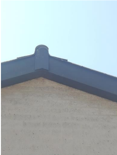
Figuur 4.4.1. De nok op gebouw I is dichtgemaakt, zodat er geen vogels in kunnen.
