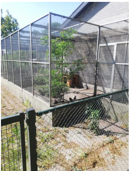
Figuur 4.1.4. Gebouw E en de er tegenaan gebouwde volièrres.
