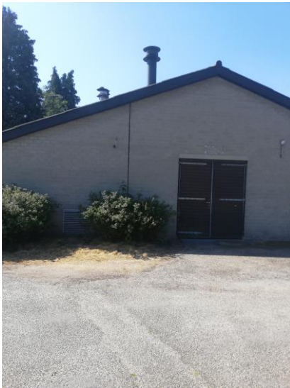
Figuur 4.1.6. Gebouw I.
