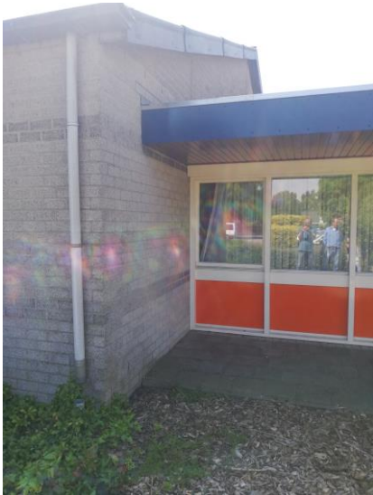
Figuur 4.1.3. Gebouw E.
