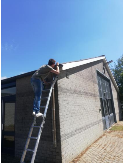
Figuur 4.1.2. Gebouw D wordt met een boomcamera geïnspecteerd.
