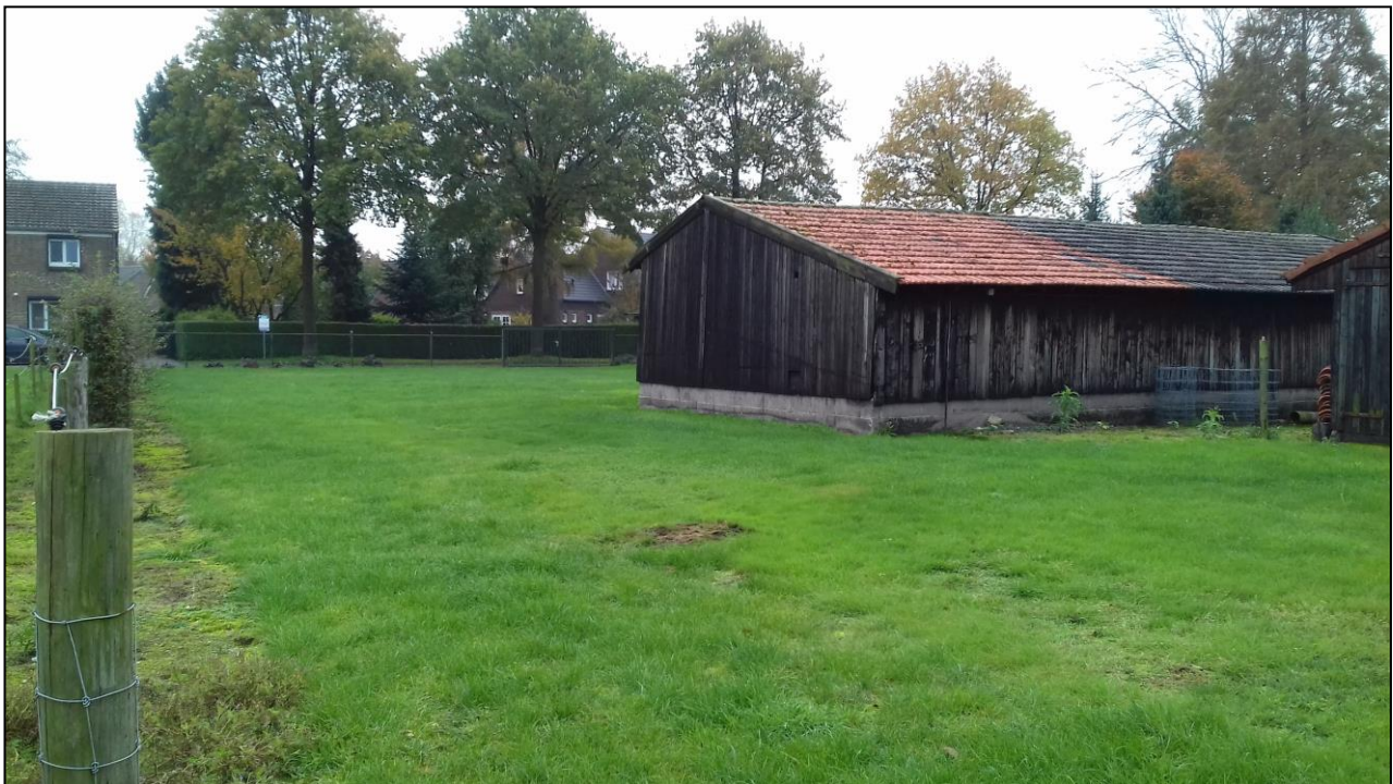
Figuur 2: Het plangebied bij aanvang van het onderzoek, gezien in zuidwestelijke richting.
