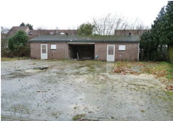
Fig 7. Overzicht van het te slopen keetje, een eensteens laag gebouwtje met twee ruimtes en een overkapping tussenin.
