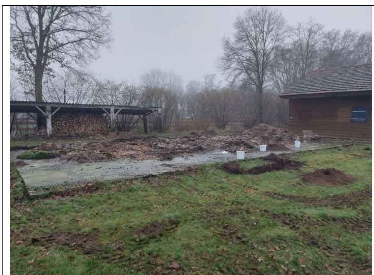
Foto 3: onderzoeklocatie gezien vanuit het noorden (12 januari 2022)
