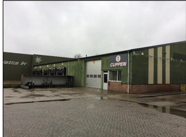
Afbeelding 5. Bestaande bedrijfsbebouwing Cuppen Logistics
