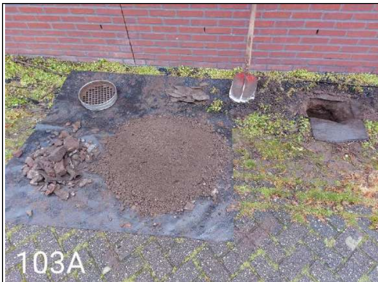
Foto 5: uitkomend materiaal proefgat 103A
