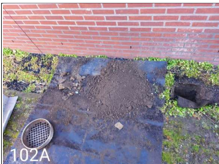
Foto 3: uitkomend materiaal proefgat 102A
