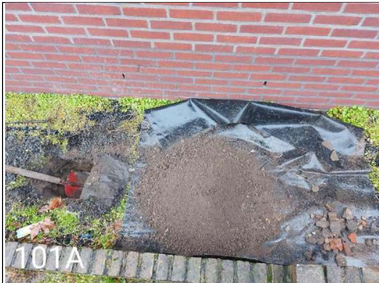
Foto 1: uitkomend materiaal proefgat 101A
