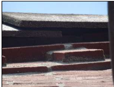
Figuur 11. Impressie toegang ruimte onder overhangende dakpannen.
