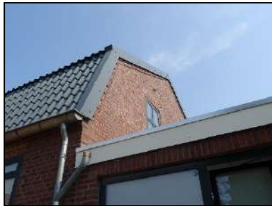
Figuur 10. Impressie overhangende dakpannen centrale gebouw aan oostelijke zijde.
