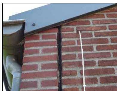
Figuur 15. Dilatatievoeg, geeft toegang tot de spouwmuren.
