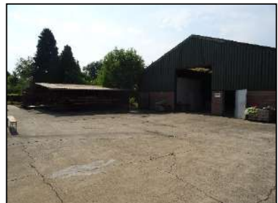
Figuur 5. Voorkant loods in het midden van de onderzoekslocatie.
