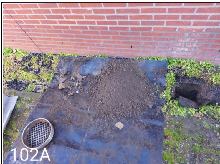
Foto 3: uitkomend materiaal proefgat 102A
