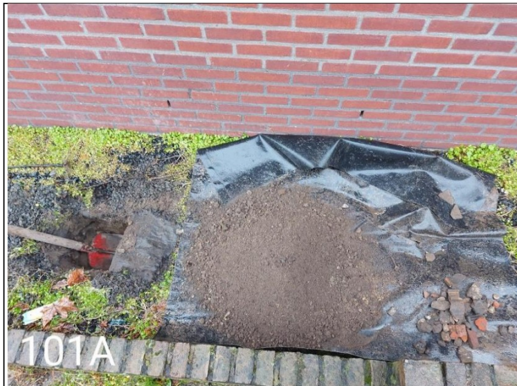
Foto 1: uitkomend materiaal proefgat 101A
