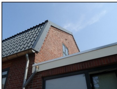
Figuur 10. Impressie overhangende dakpannen centrale gebouw aan oostelijke zijde.
