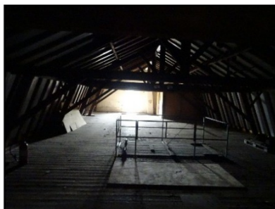
Figuur 7. Zolder schuur noordkant onderzoekslocatie..
