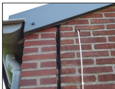
Figuur 15. Dilatatievoeg, geeft toegang tot de spouwmuren.
