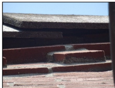
Figuur 11. Impressie toegang ruimte onder overhangende dakpannen.
