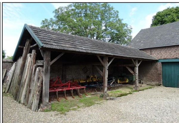
Figuur 7. Aanzicht open schuur voor opslag werktuigen
