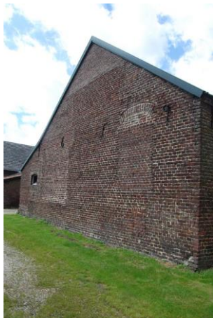
Afbeeldingen 8 en 9. Links de oostelijke kopgevel van de schuur, met bouwsporen van het voormalige woonhuis en de in deze gevel hergebruikte ankers die eerst in de naar het zuiden gerichte voorgevel van Huis Steenhagen waren gebruikt. Rechts de naar het erf gerichte zuidgevel van de schuur. Behalve oud metselwerk is hier weinig van de oorspronkelijke gevel bewaard gebleven. (Foto's Thijs Pubben, 4 juli 2016.)
