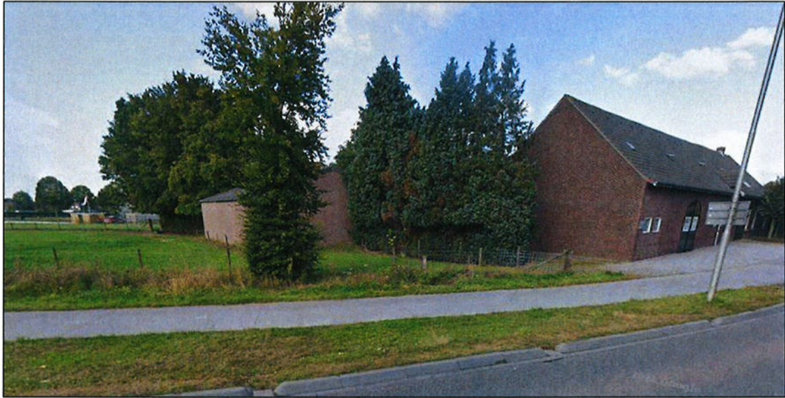
Afbeelding 5 Woning Stationsstraat 62 met daarachter open gebied
