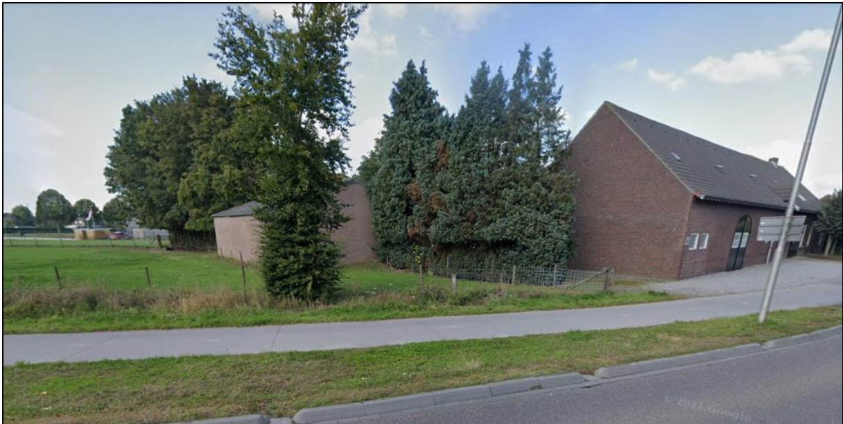
Afbeelding 5 Woning Stationsstraat 62 met daarachter open gebied
