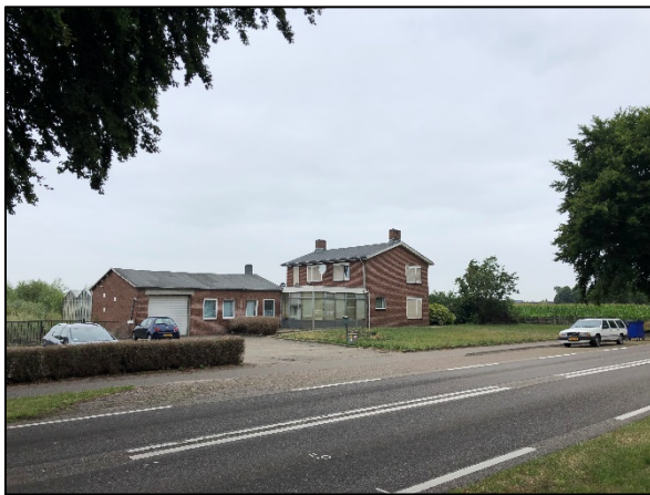
Afbeelding 6. Woning Stationsstraat 80 met daarachter open gebied
