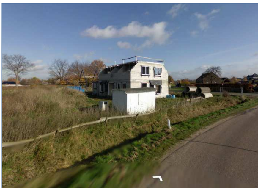
Afbeelding 3. In aanbouw zijnde woning hoek Kraneveldweg - Kranestraat
