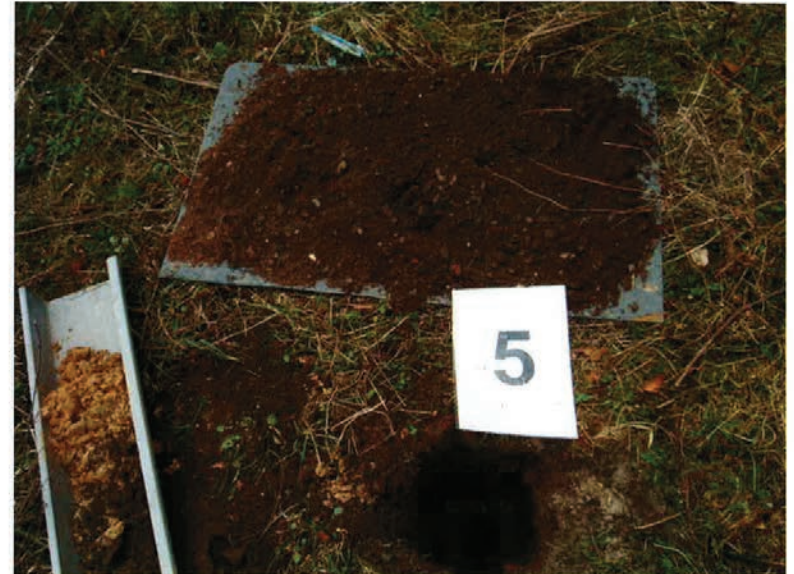
Foto 5: uitgekomen materiaal inspectiegat 5
