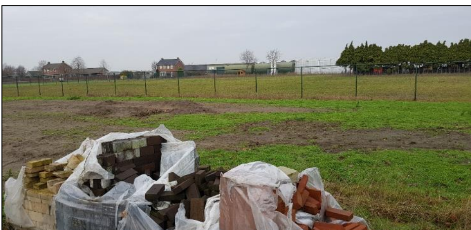
Figuur 3 Huidige situatie beoogde locatie constructie- en praktijkruimte
