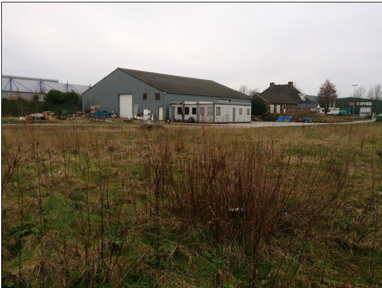
Figuur 2: plangebied bij aanvang van de werkzaamheden in zuidwestelijke richting.
