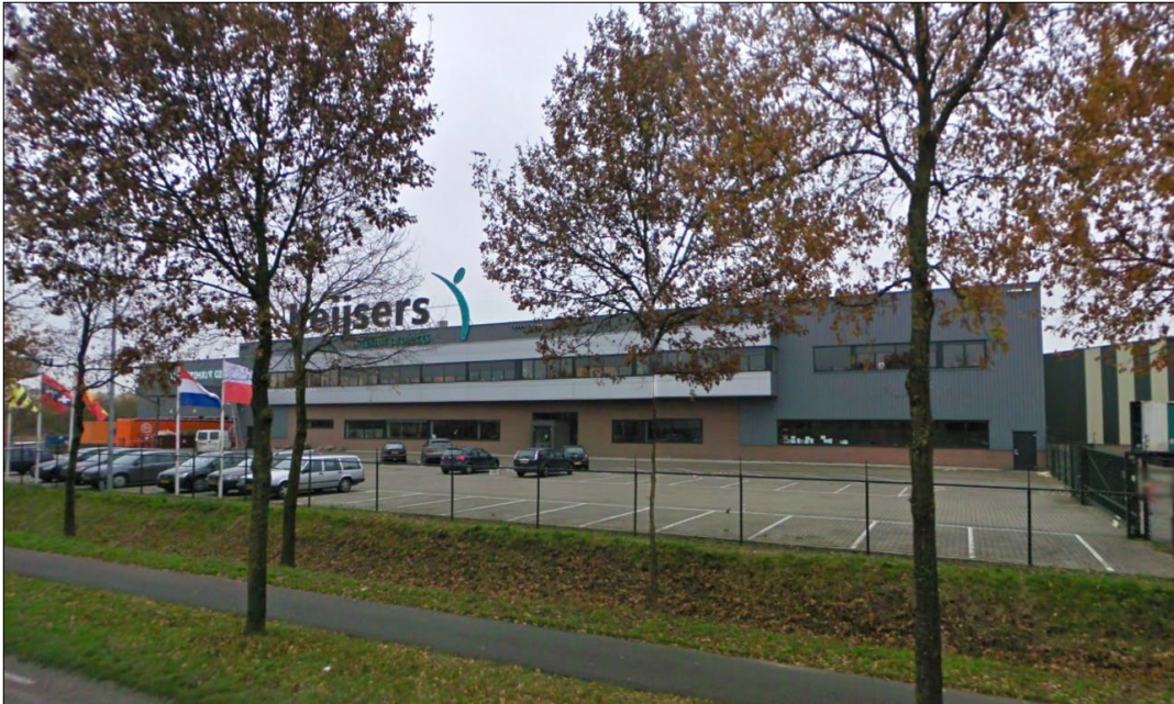
bebouwing aan de overzijde van het plangebied
