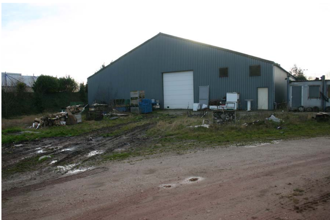
Figuur 3.2. Perceel 2a bevat verschillende gebouwen, waaronder deze loods.
