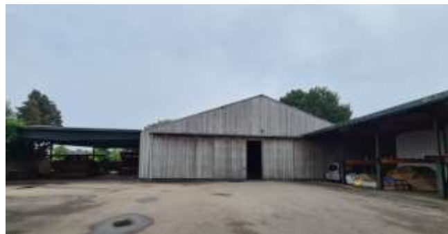
Figuur 8: Te midden van deze foto is een van de bedrijfshallen, links en rechts aansluitend zijn een 2-tal opstallen gesitueerd
