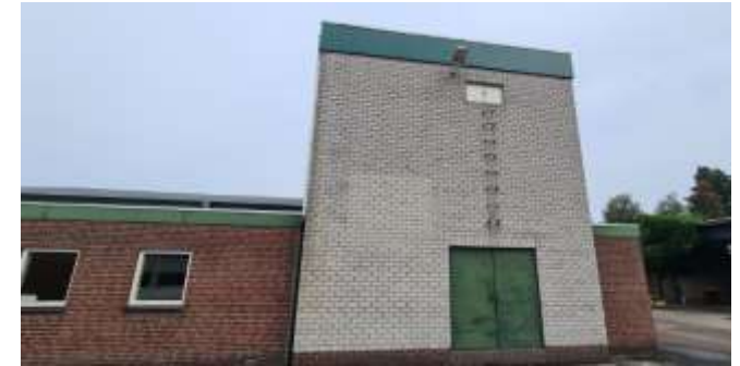
Figuur 5: Bedrijfshal tegen de noordelijke erfgrans
