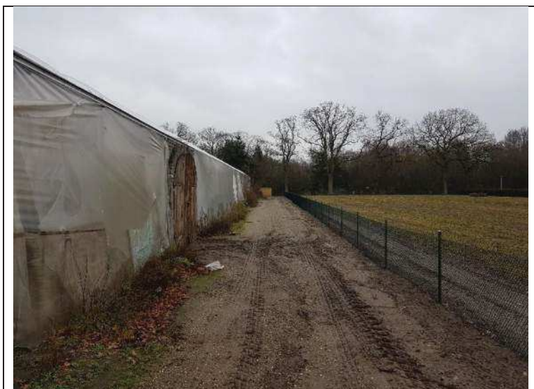
foto 15: pad met halfverharding (deellocatie H) (gezien vanuit het noorden, 17 december 2018)
