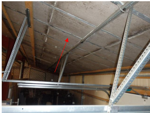
impressie van asbest dakplaten
