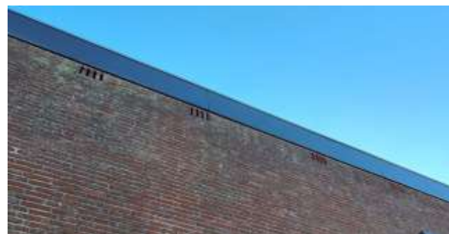
Figuur 8: Ventilatievoegen in de westgevel
