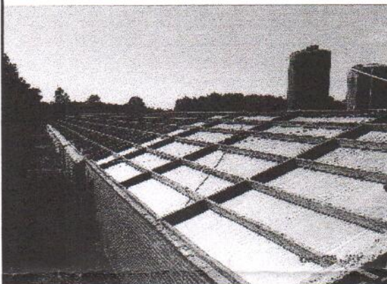
Foto 17 overzicht dak stal 1
