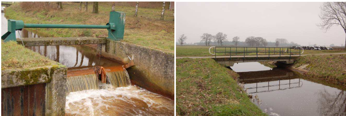
Figuur 8, Brug bij de weg Diepeleng en stuw in Lollebeek ten oosten van de weg Diepeleng
