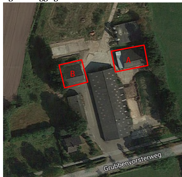
Figuur 2: Ligging schuren met asbesthoudend dak
