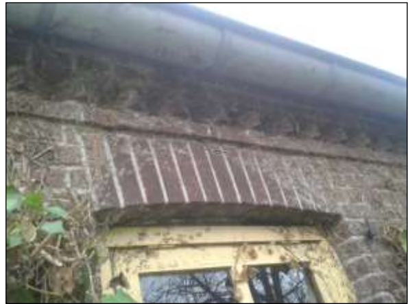
Figuur 6: Foto links: Originele muurankers zorgen voor de verbinding tussen de draagbalken en de buitenmuur. Dit zorgt voor de stabiliteit van het gebouw. Foto rechts: Metselwerk in de vorm van hanenkam. De hanenkam geeft de constructie extra sterkte, zodat het gewicht van de bouwdeelen opgevangen kan worden.
