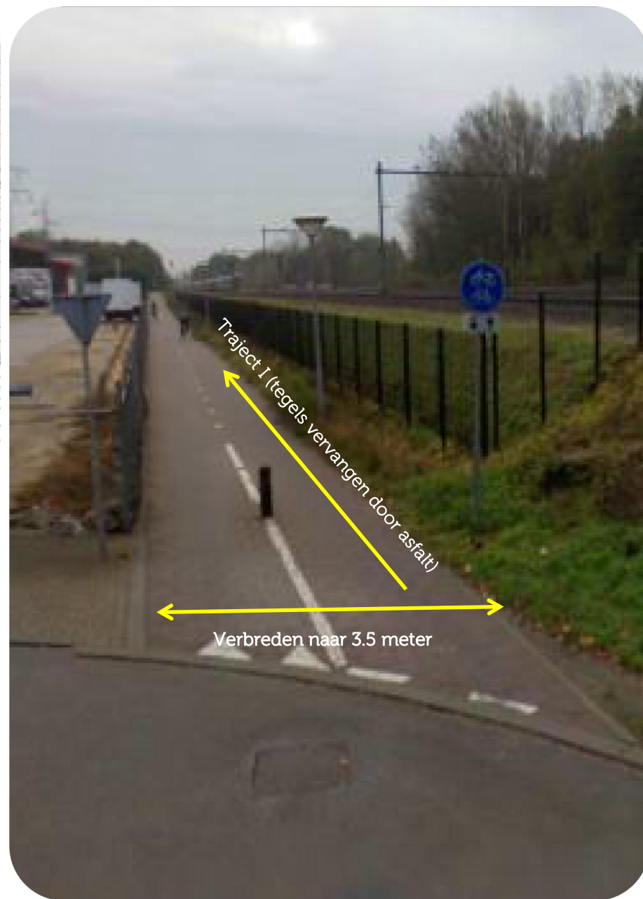
Traject I. Fietsoversteek → tegels vervangen door rood asfalt en verbreden na 3.5 m.
