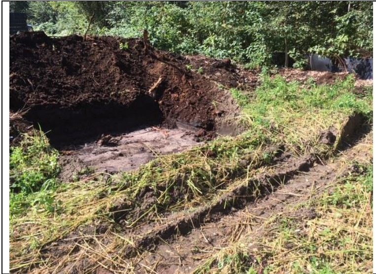
Foto 1: overzicht ontgravingsput (gezien vanuit het noordoosten, 30 augustus 2019)
