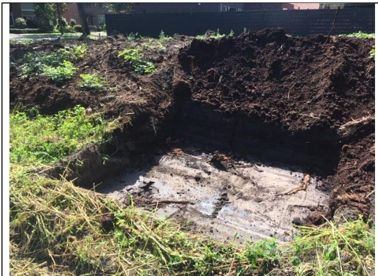
Foto 2: overzicht ontgravingsput (gezien vanuit het noordwesten, 30 augustus 2019)
