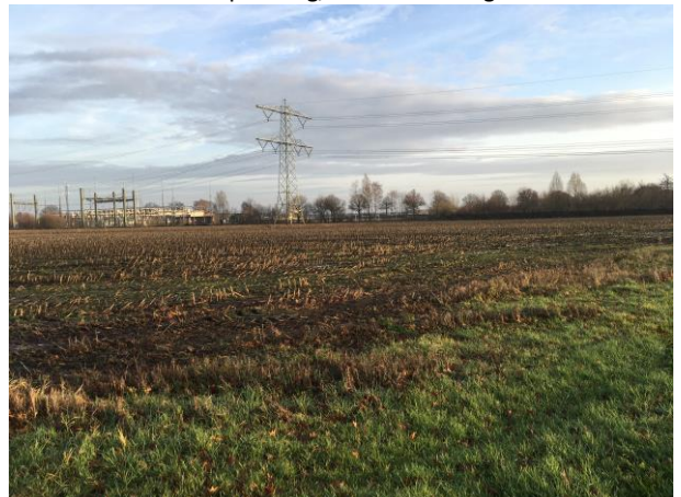
Foto 12 Uitzicht op hoogspanningsleiding en verdeelstation Enexis
