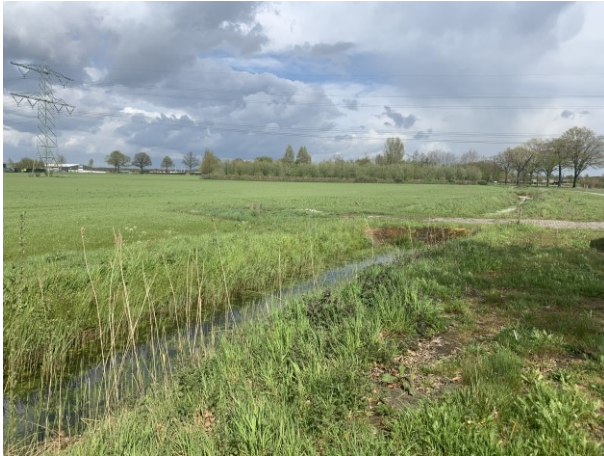
Foto 7 Aanzicht hoogspanningsleiding vanuit Sevenumseweg
