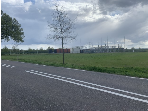
Foto 13 Verdeelstation Enexis gelegen aan de Horserweg
