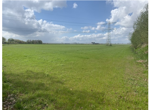
Foto 8 Aanzicht hoogspanningsleiding vanuit Sevenumseweg
