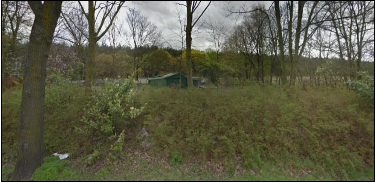
Afbeelding 13. Huidige bebouwing vanuit straatzijde
