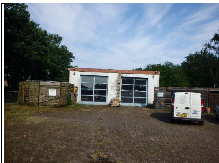
Foto 2: niet meer in gebruik zijnde garage gezien vanuit het oosten (22 mei 2018)
