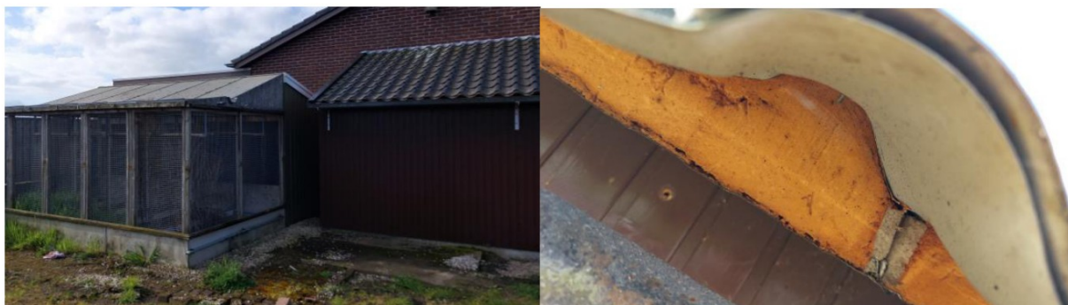
Figuur 4.2.3. Enkelwandig bijgebouw en vogelvolière (links) en sandwichpanelen dak (rechts).
