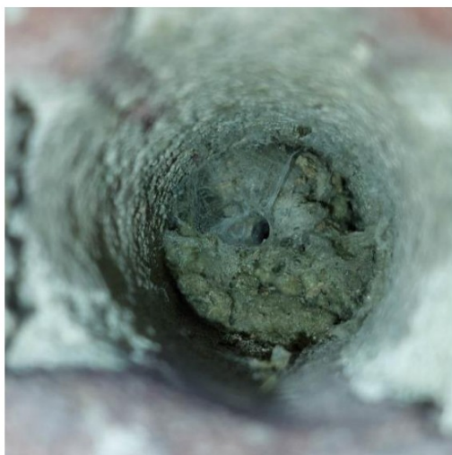
Figuur 4.2.2. In de spouw van de bedrijfswoning zit isolatiewol.
