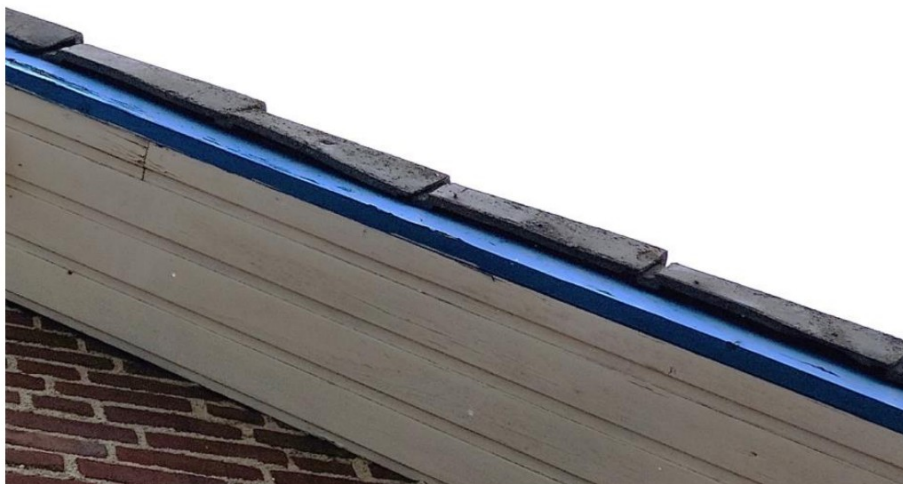
Figuur 4.2.5. Vleermuizen kunnen onder de overstekende gevelpannen invliegen.
