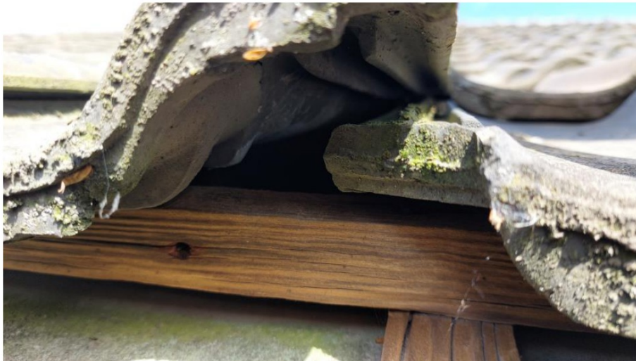
Figuur 4.2.3. Vogelschroot is afwezig bij de bedrijfswoning.
