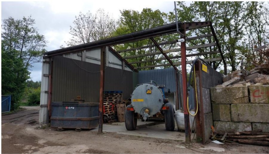
Figuur 4.2.1. Het deels afgebroken gebouw bestaat alleen nog uit enkele enkelwandige gevels.
