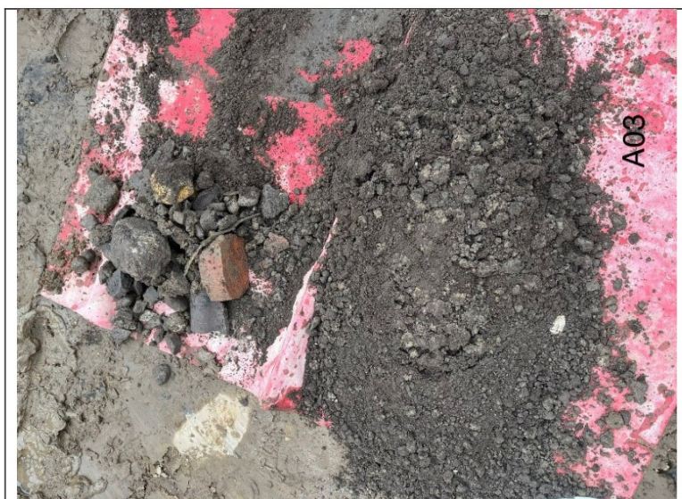
Foto 12: Uitsluitend materiaal proefgat A03
