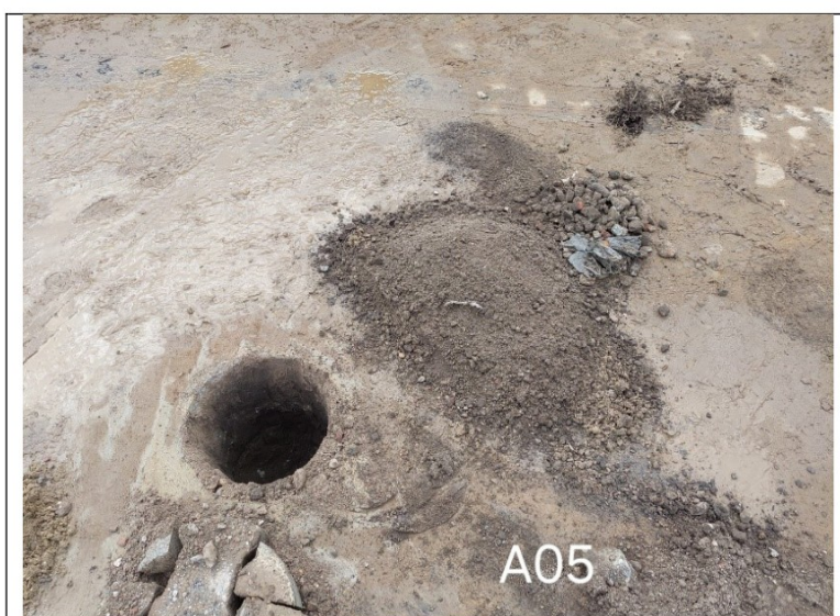
Foto 13: Uitsluitend materiaal proefgat A05
