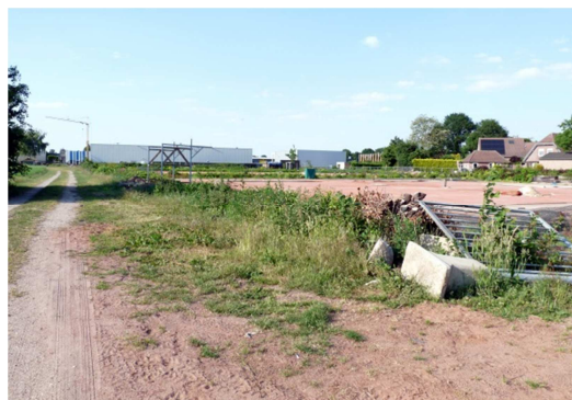
Foto 14 Situatie in het voorjaar, overzicht vanaf het pad langs de tennisbanen. Foto genomen 22-06-2015
