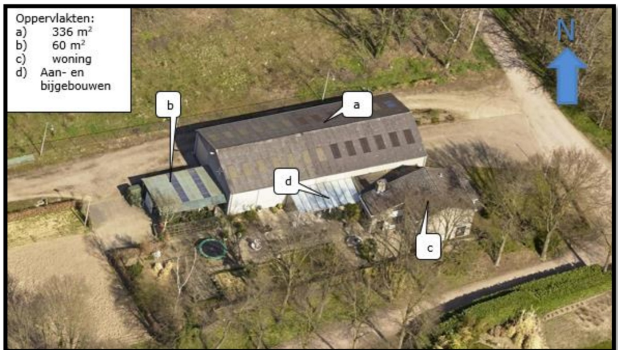
Afbeelding 3. Luchtfoto huidige situatie.
