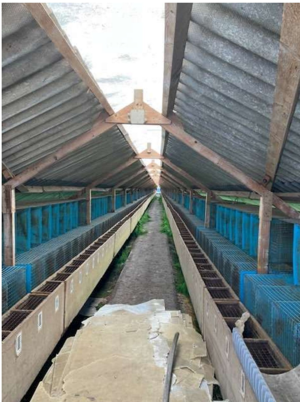
• Afbeelding 6: Binnenzijde sheds
