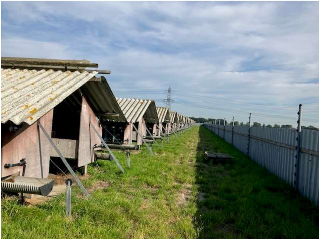
• Afbeelding 4: Achterzijde van de sheds
