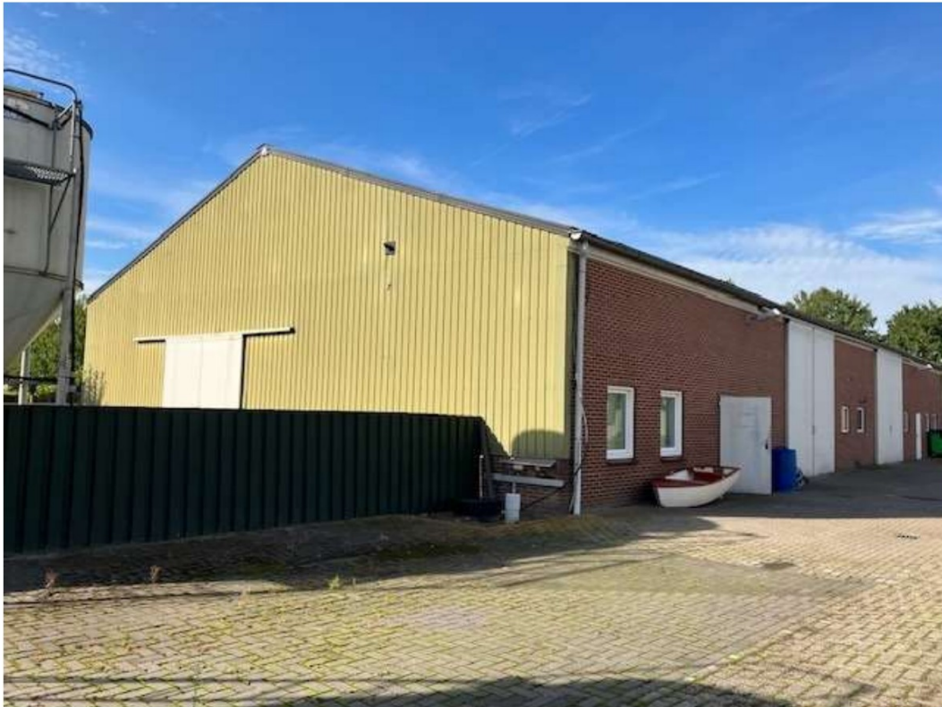
• Afbeelding 8: Loods die behouden blijft
