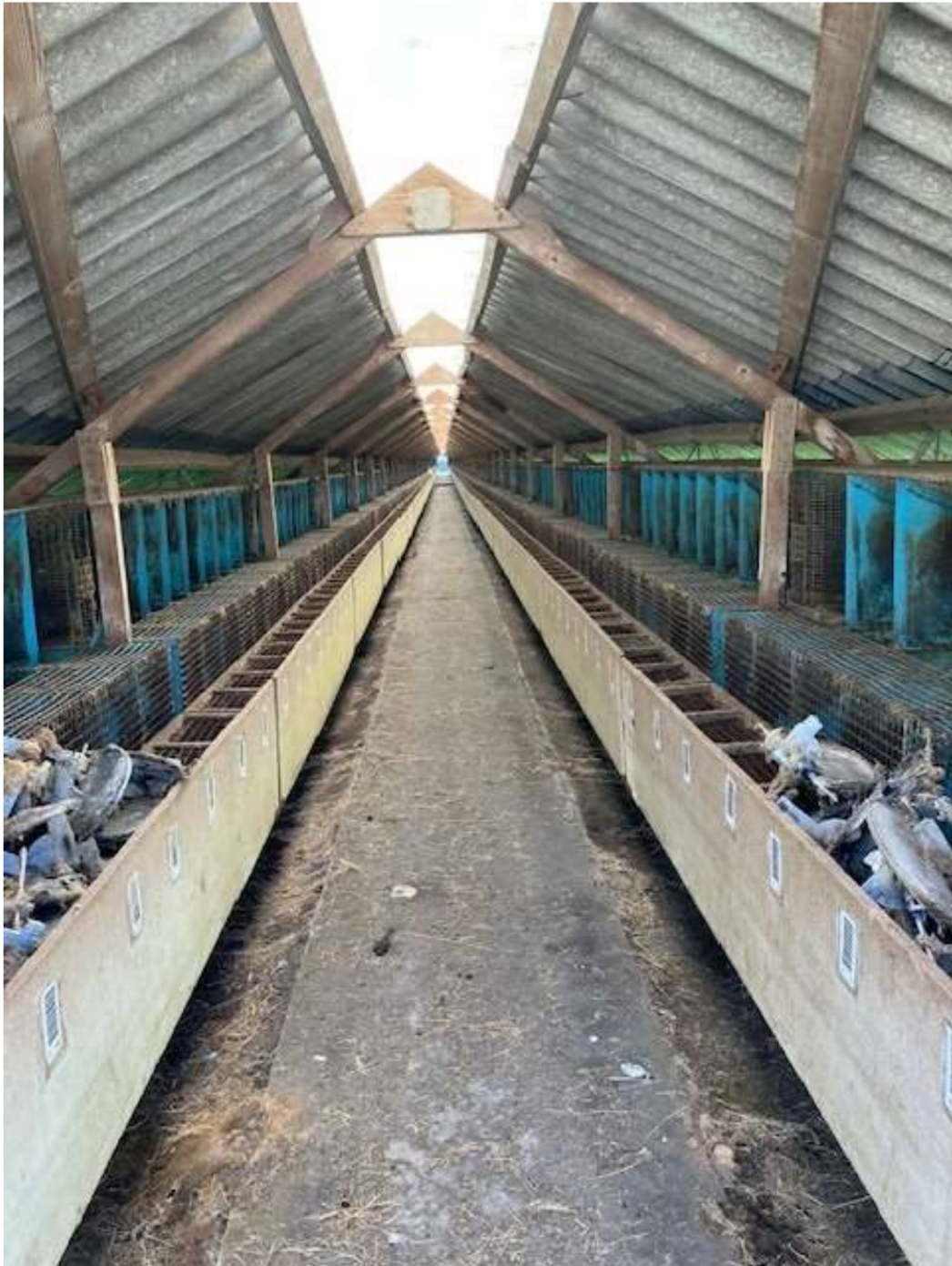
• Afbeelding 7: Binnenzijde sheds
