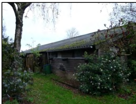
Figuur 12. Golfplaten dak op voormalige koeienstal.
