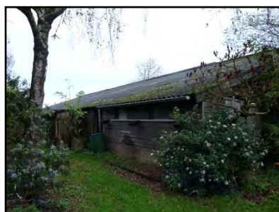
Figuur 7. Voormalige koeienstal.
