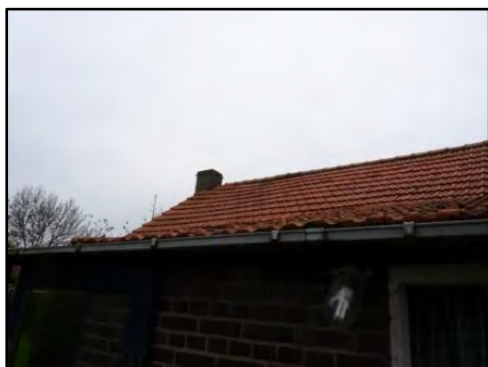
Figuur 11. Geschikte openingen ter hoogte van de dakgoot aan het woonhuis.
