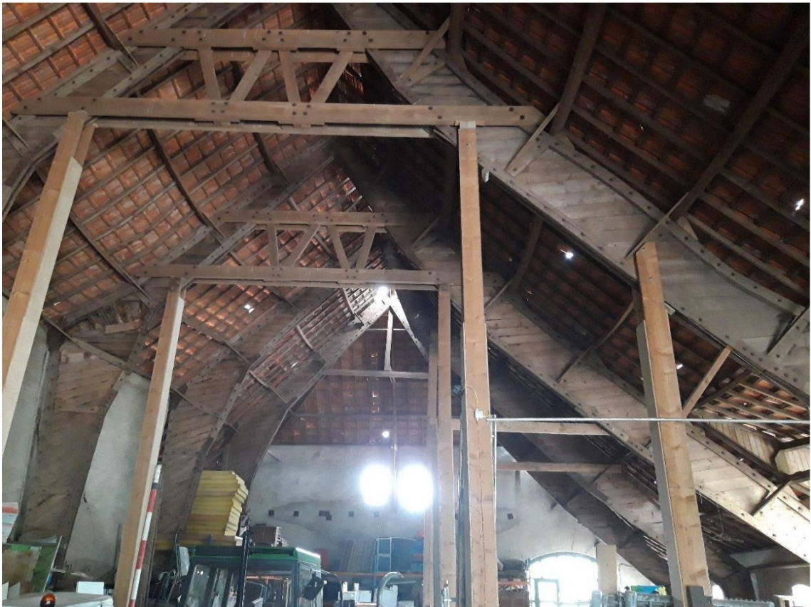
Afbeelding 5. Binnenzijde van de te slopen schuur.
