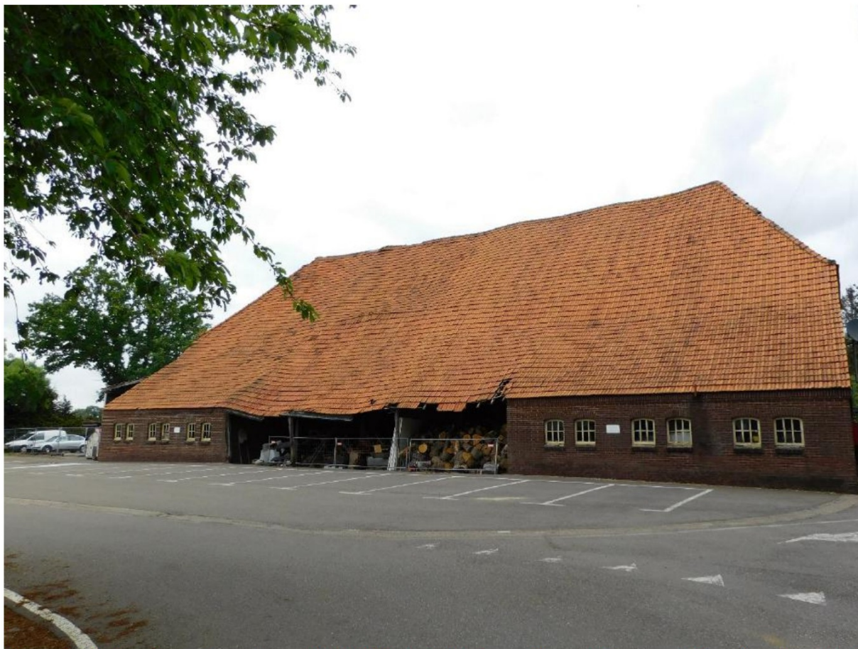
Figuur 7 - Schuur in wederopbouwstijl (1948); het dak is ernstig gedefformeerd. Daardoor is ook het muurwerk deels beschadigd.
